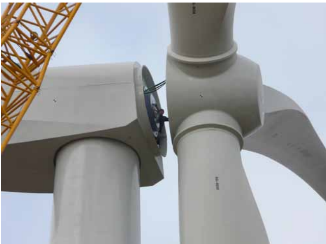
Millimeterarbeit in schwindelnder Höhe: 80 Meter über dem Boden wird der Rotor an der Nabe befestigt – in diesem Fall an einer MM82 des deutschen Herstellers Repower. Die Anlage hat ABO Wind im vergangenen Jahr in Berviller (Lothringen) errichtet
