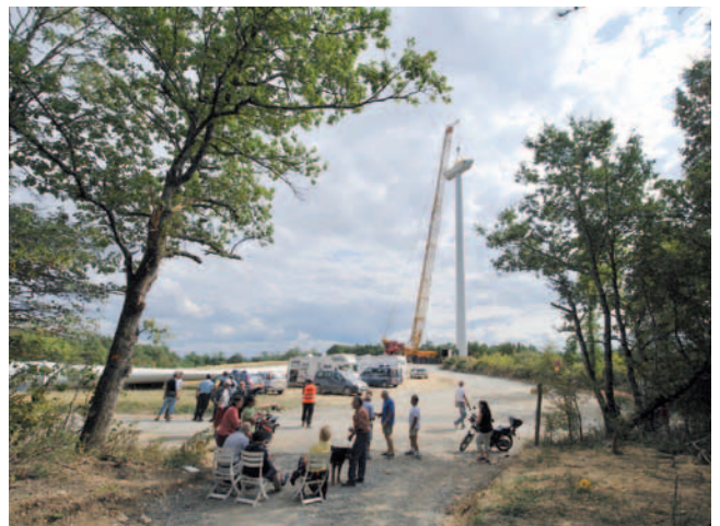
Eine Attraktion für die Nachbarn war im vergangenen Jahr der Aufbau des Windparks Cuq im südfranzösischen Département Tarn et Garonne.
