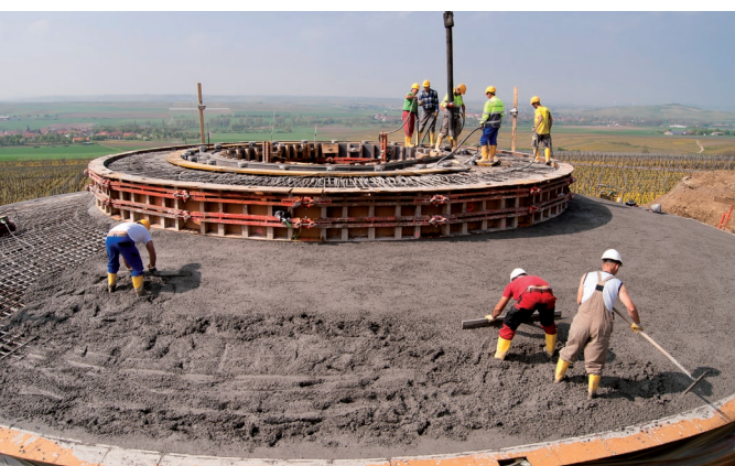
La fondation pour l'arrivée de la nouvelle éolienne.
