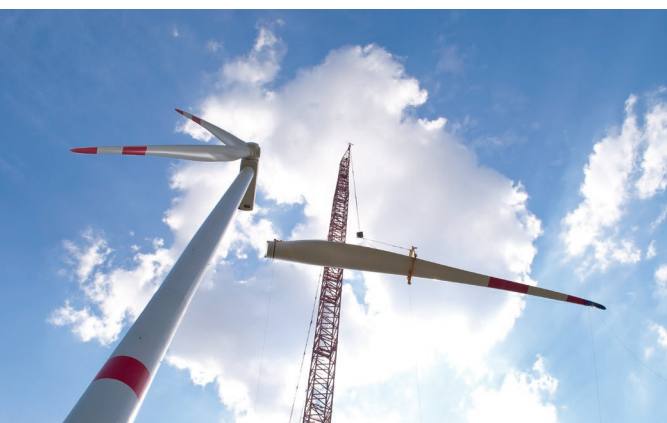
La dernière pale de rotor est installée.
