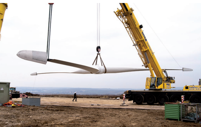
Démontage du rotor d'une éolienne de première génération.
