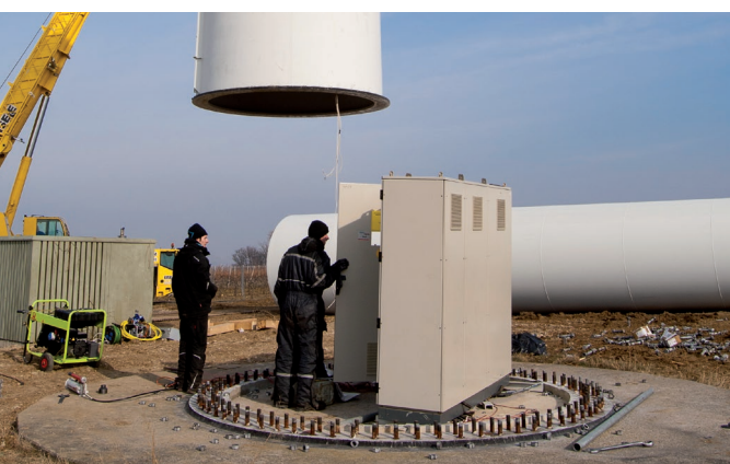
Le mat a été démantelé, les armoires de commande sont toujours là.
