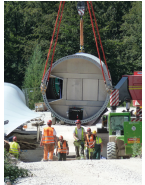
Nach der Anlieferung der Komponenten dauert die eigentliche Errichtung der Anlage nur wenige Tage.
