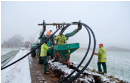
Das Kabelsystem verläuft entlang bestehender Wege.
