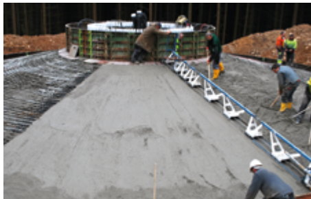
Ein Fundament wird gegossen.
