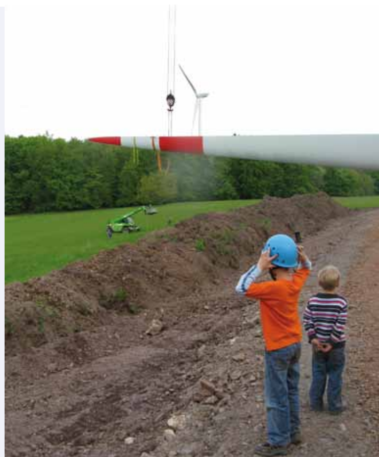
Aufbau der Anlage Berschweiler / Erection of Berschweiler wind farm
