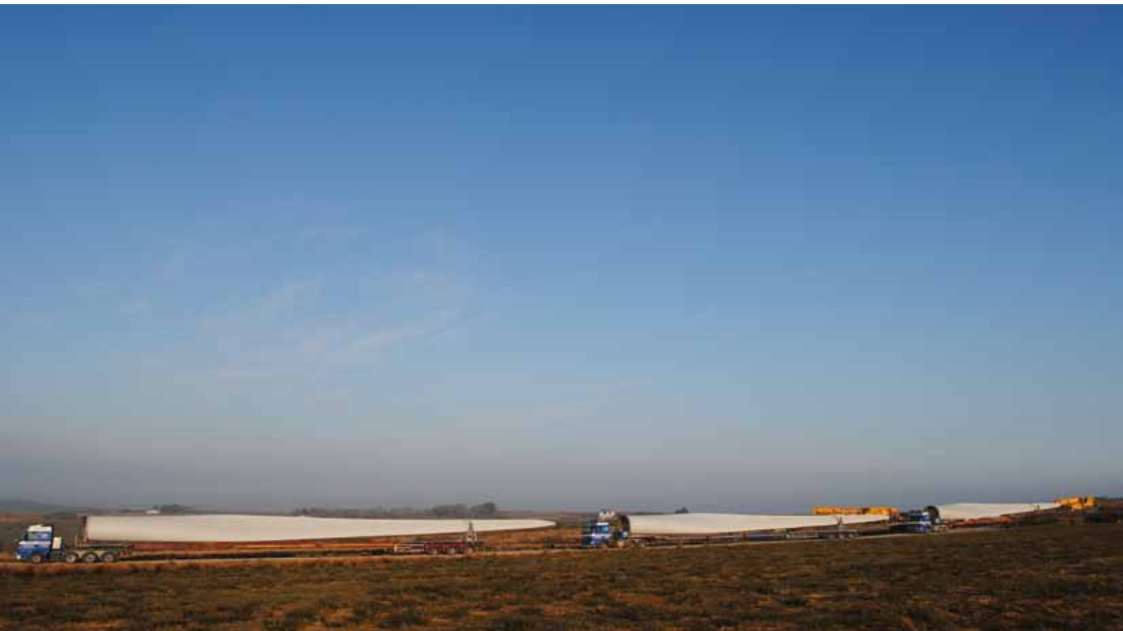
Anlieferung der Rotorblätter in Gortahile/ Turbine blade delivery in Gortahile
