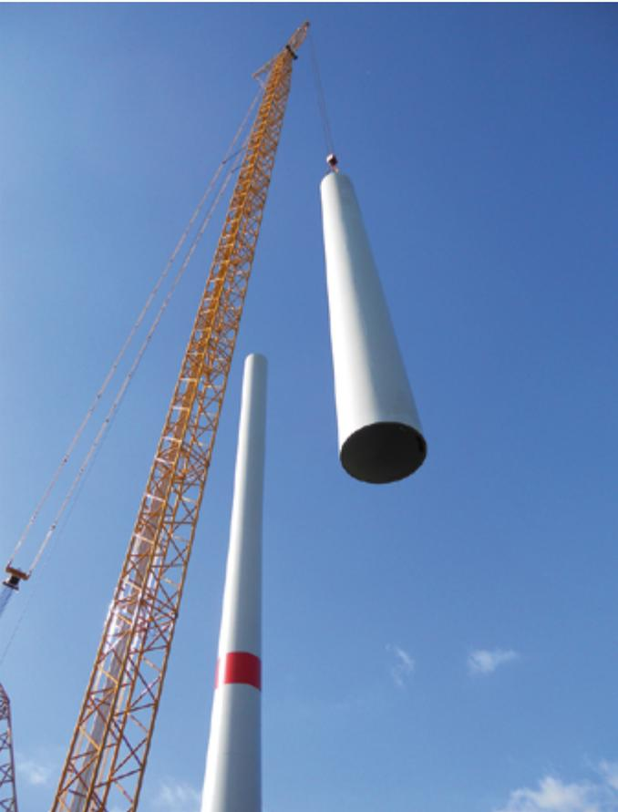
... auf die anschließend Stahlrohrsegmente gesetzt werden.
