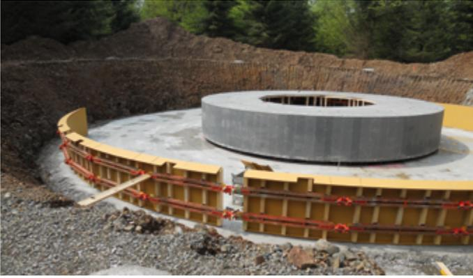
Auf einer Grundfläche von 400 Quadratmetern entsteht das Fundament der Windkraftanlage. Der Durchmesser beträgt 22,5 Meter.
