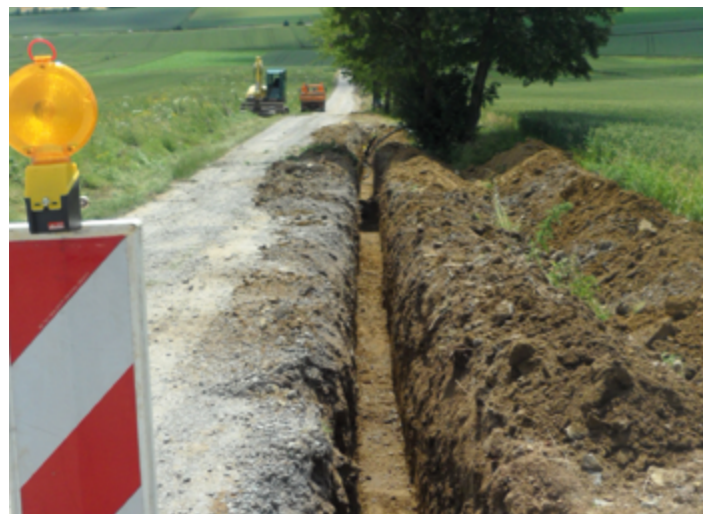
Das Kabelsystem zum Stromtransport wurde entlang bestehender Wege verlegt.
