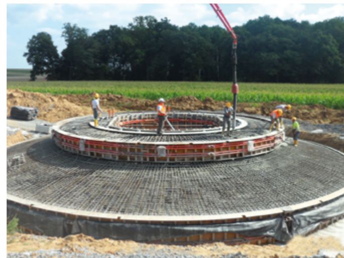
Das Fundament einer Anlage wird betoniert.
