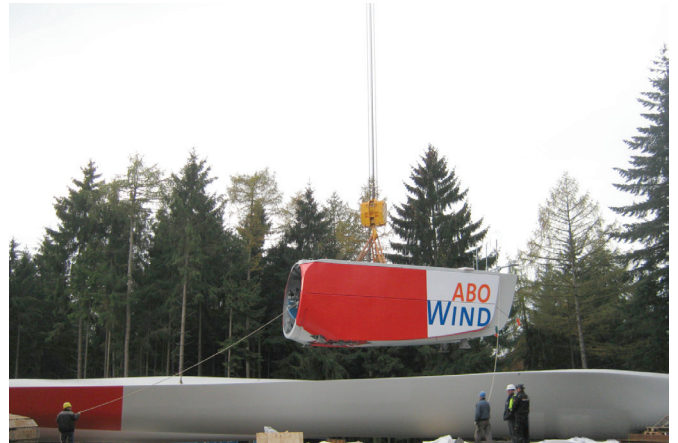
Die Montage der einzelnen Bauteile, aus denen die Anlage besteht, wird vorbereitet.
