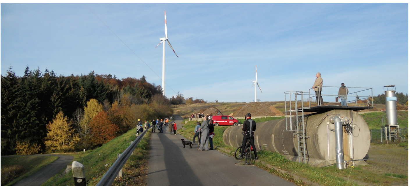
Der Aufbau eines Windrades begeistert: Zu den Baustellen im Schelder Wald kamen viele Besucher, die die faszinierende Technik aus der Nähe sehen wollten.
