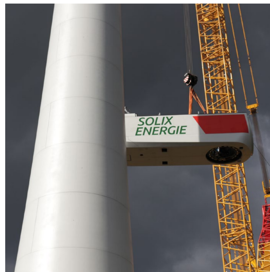
Errichtung der Anlage in Lahr im Frühjahr 2016
