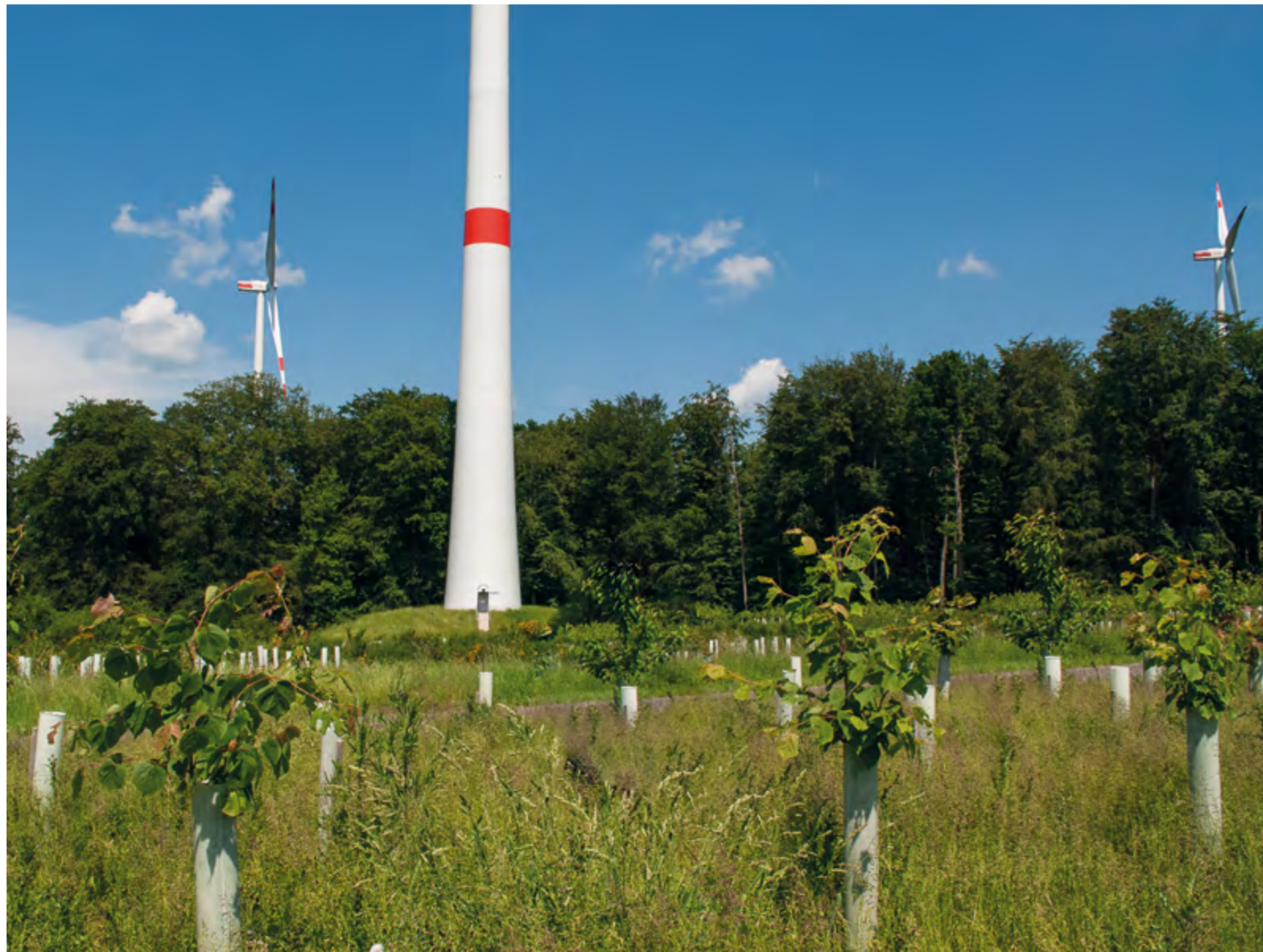
Der Windpark in Schnorbach entstand im monokulturell geprägten Wirtschaftswald. Im Zuge des Baus erfolgten Erstaufforstungen von Laubmischwäldern aus regionalen Gehölzen.
