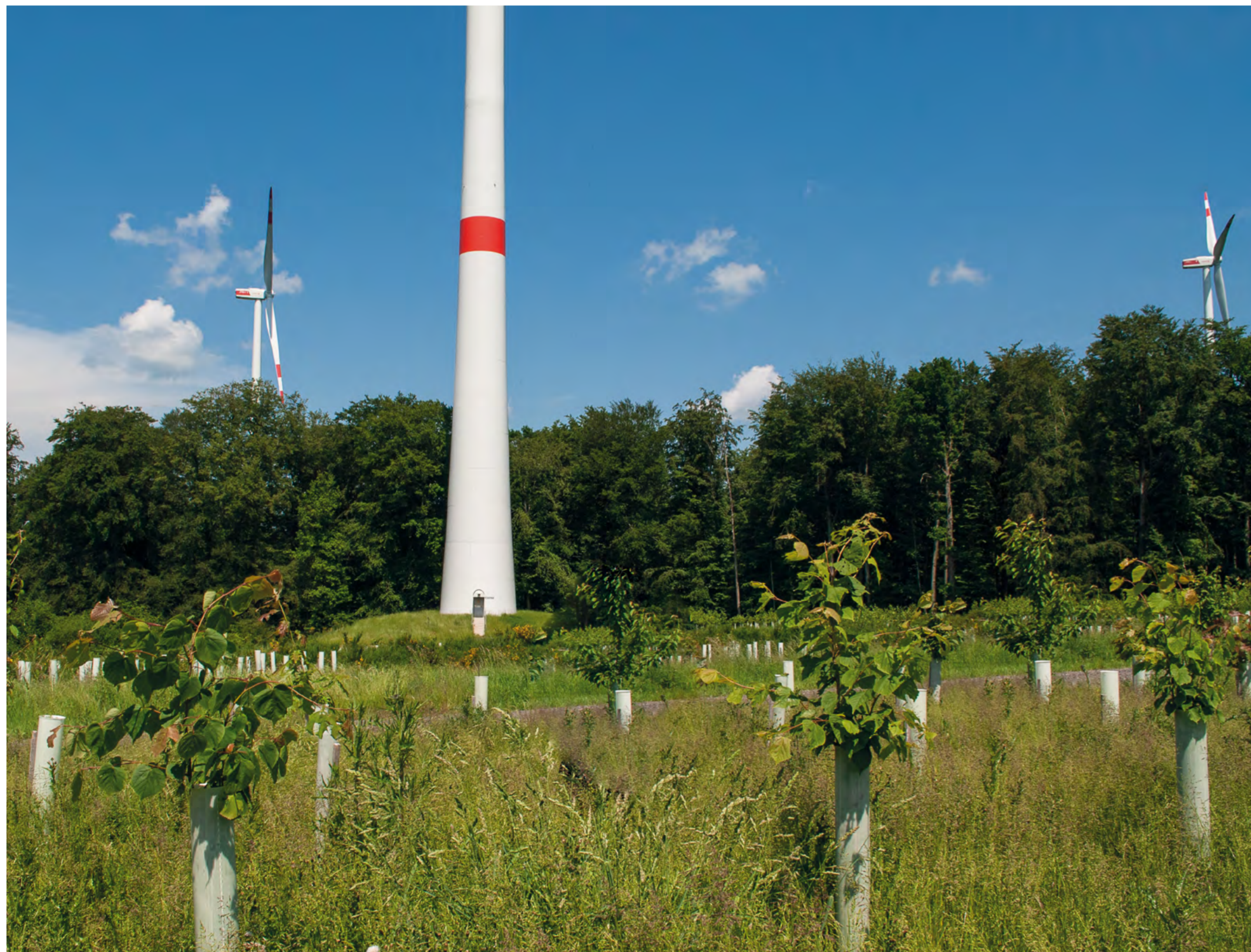
Der Windpark in Schnorbach entstand im monokulturell geprägten Wirtschaftswald. Im Zuge des Baus erfolgten Erstaufforstungen von Laubmischwäldern aus regionalen Gehölzen.
